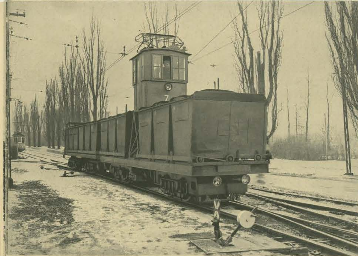
Güterzug mit fahrbaren Behältern für Kohlentransport (2,5 t Nutzinhalt je Behälter)
