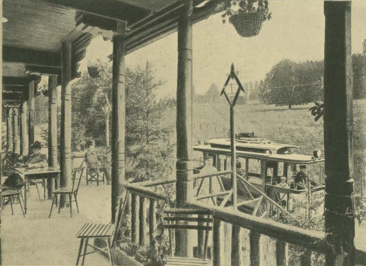
Vorhalle der Endstation zur Gründungszeit
