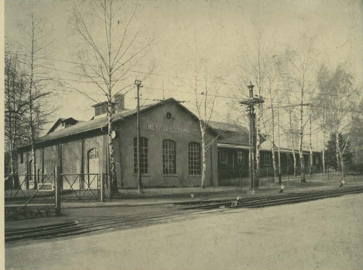
Betriebsbahnhof Dönche (im Vordergrund das Umformerwerk)
